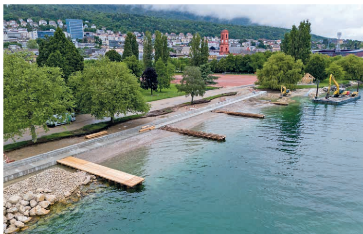
Les pontons sont en train d'être recouverts de bois. LUCAS VUITEL
