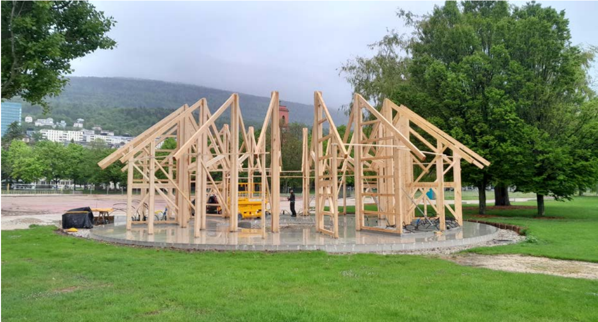
Photo 5 : Vestiaire en cours de construction.
